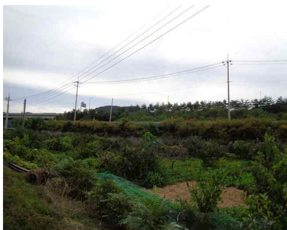
3공구 블럭식 옹벽 03
