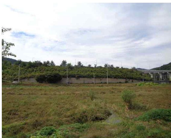
5공구 블럭식 옹벽 06
