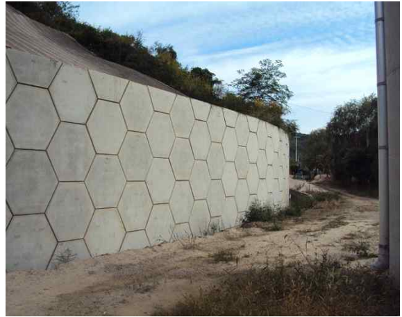
8공구 패널식 옹벽 14
