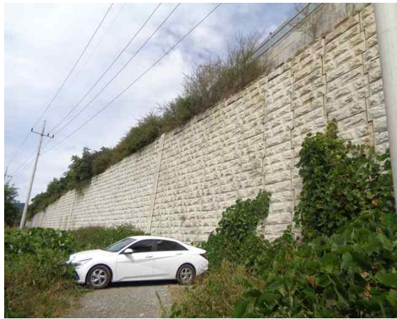
6공구 패널식 옹벽 07
