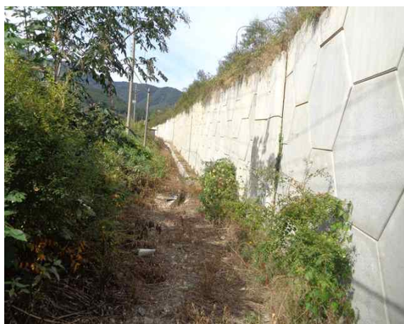
7공구 패널식 옹벽 11
