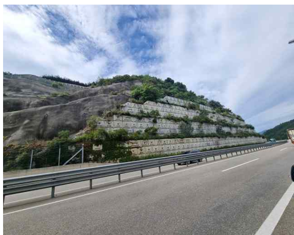
4공구 패널식 옹벽 05
