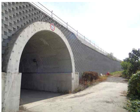
6공구 블럭식 옹벽9
