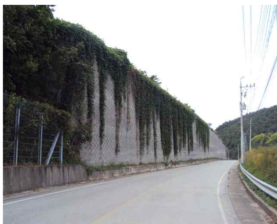
4공구 블럭식 옹벽 04
