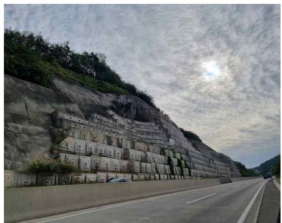
6공구 패널식 옹벽 10
