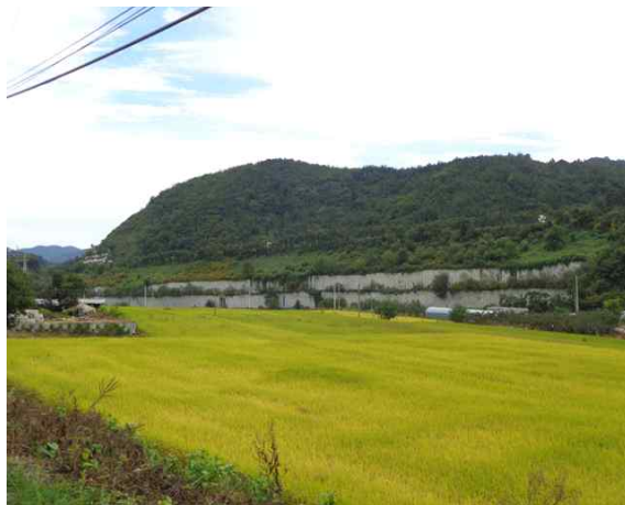
3공구 패널식 옹벽 02
