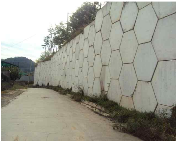
9공구 패널식 옹벽 15
