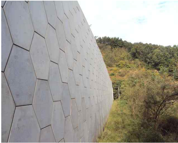
8공구 패널식 옹벽 13
