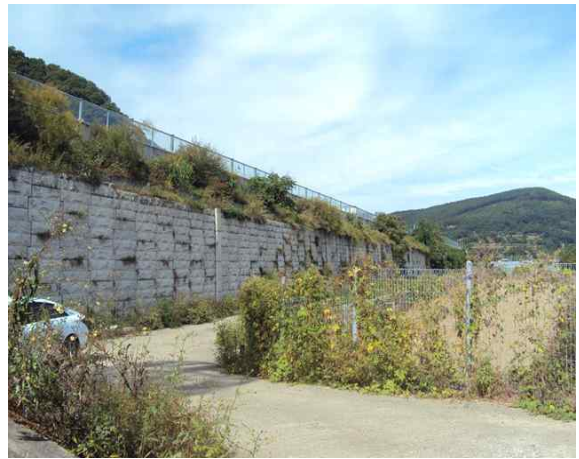
6공구 패널식 옹벽 08
