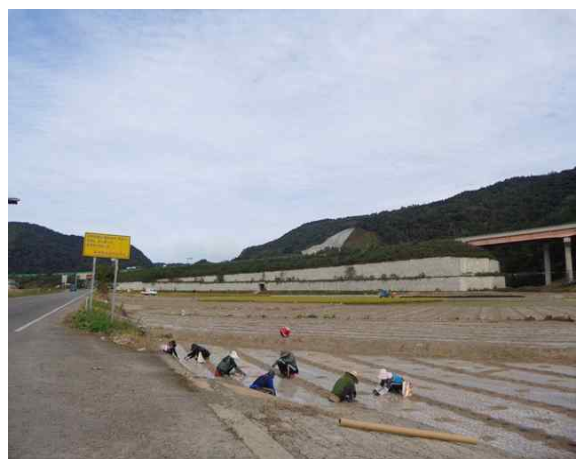
7공구 패널식 옹벽 12
